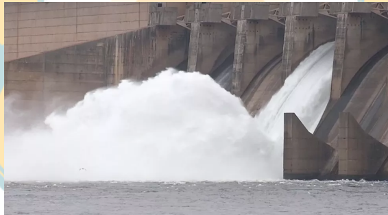
Figura 2: Vertedouro com comporta aberta na Usina Hidrelétrica de Ilha Solteira (SP). Fonte: TV TEM - G1 2 .
